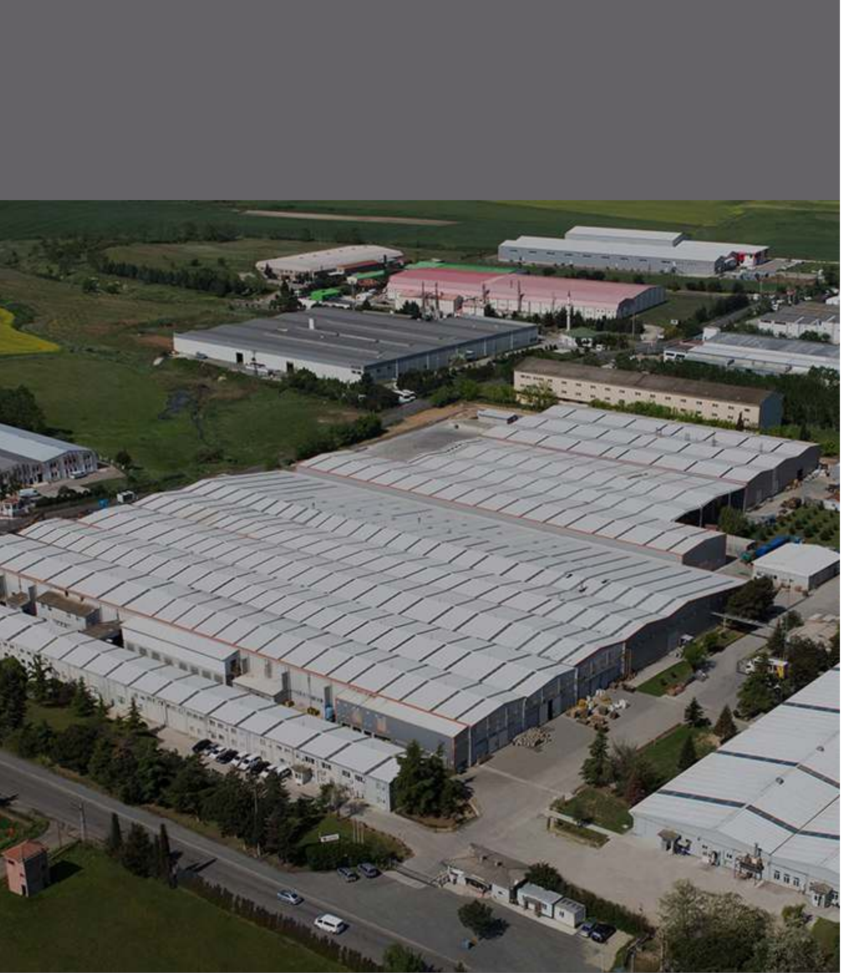
Termo Teknik Çorlu Üretim Tesisleri
